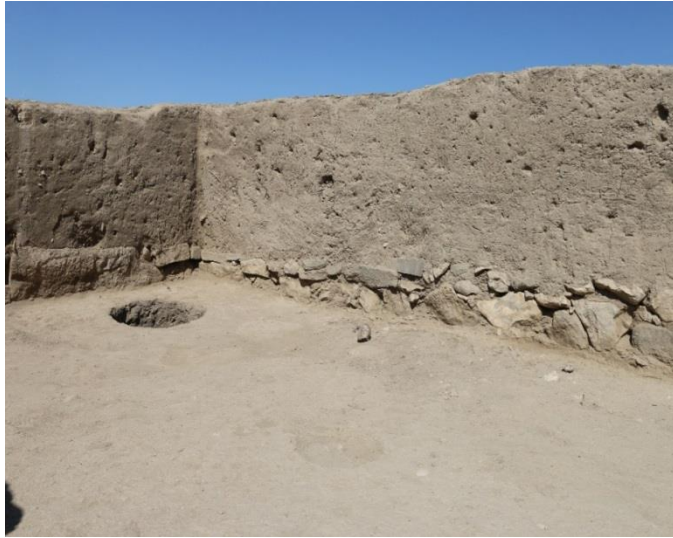
Res. 2.10.: Van Kalesi Höyüğü Erken Evre Yapı Katı duvar temelleri (Vantam Arşivi)
