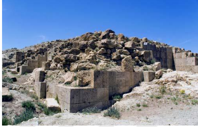
Res. 2.1.: Çavuştepe Kalesi sur duvarları ana kayaya oturtulmuş (Can Avcı Arşivi)
