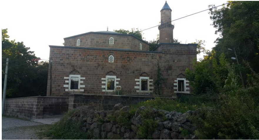
Şekil 3.14. İskender Paşa Camii
