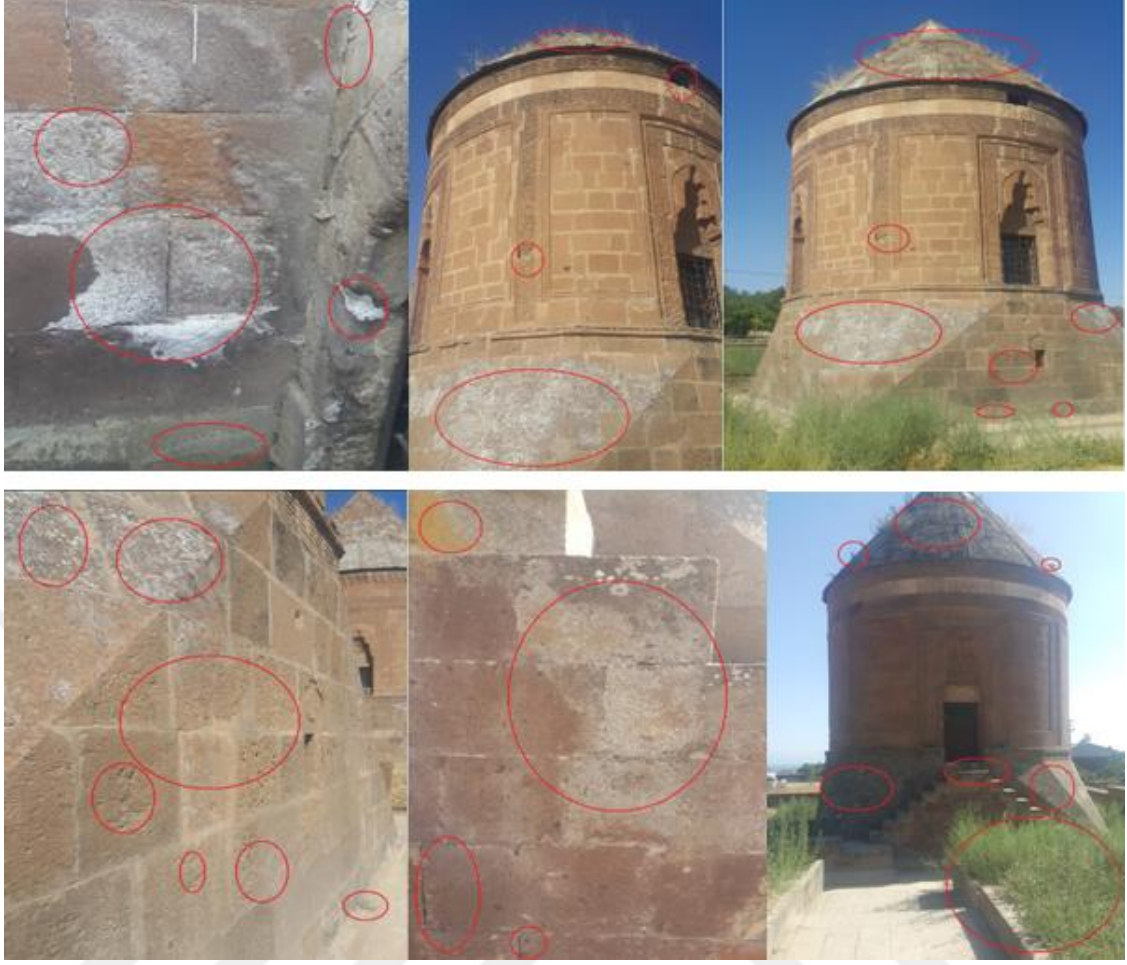
Şekil 4.13. Hüseyin Timur Kümbetinde gözlemlenen hasarlar
