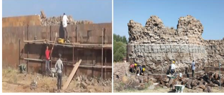
Şekil 3.8. Ahlat Sahil Kalesinde restorasyon çalışmaları
