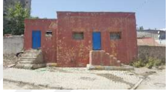
(d) Murat Paşa Su Deposu
